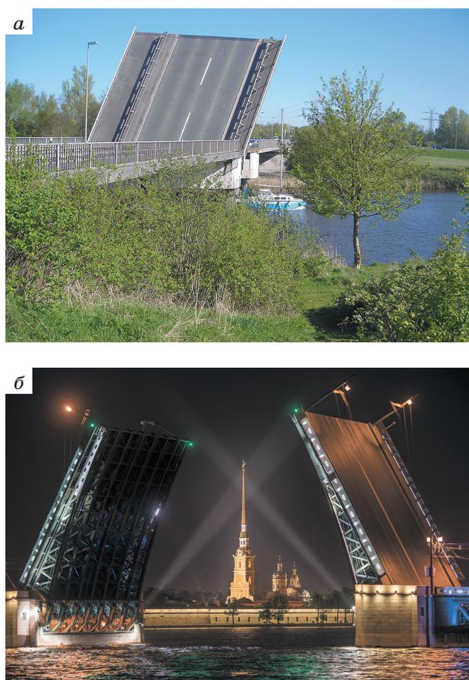
**Рис. 30.2.** Разводные мосты: *а* — однокрылый; *б* — двукрылый
