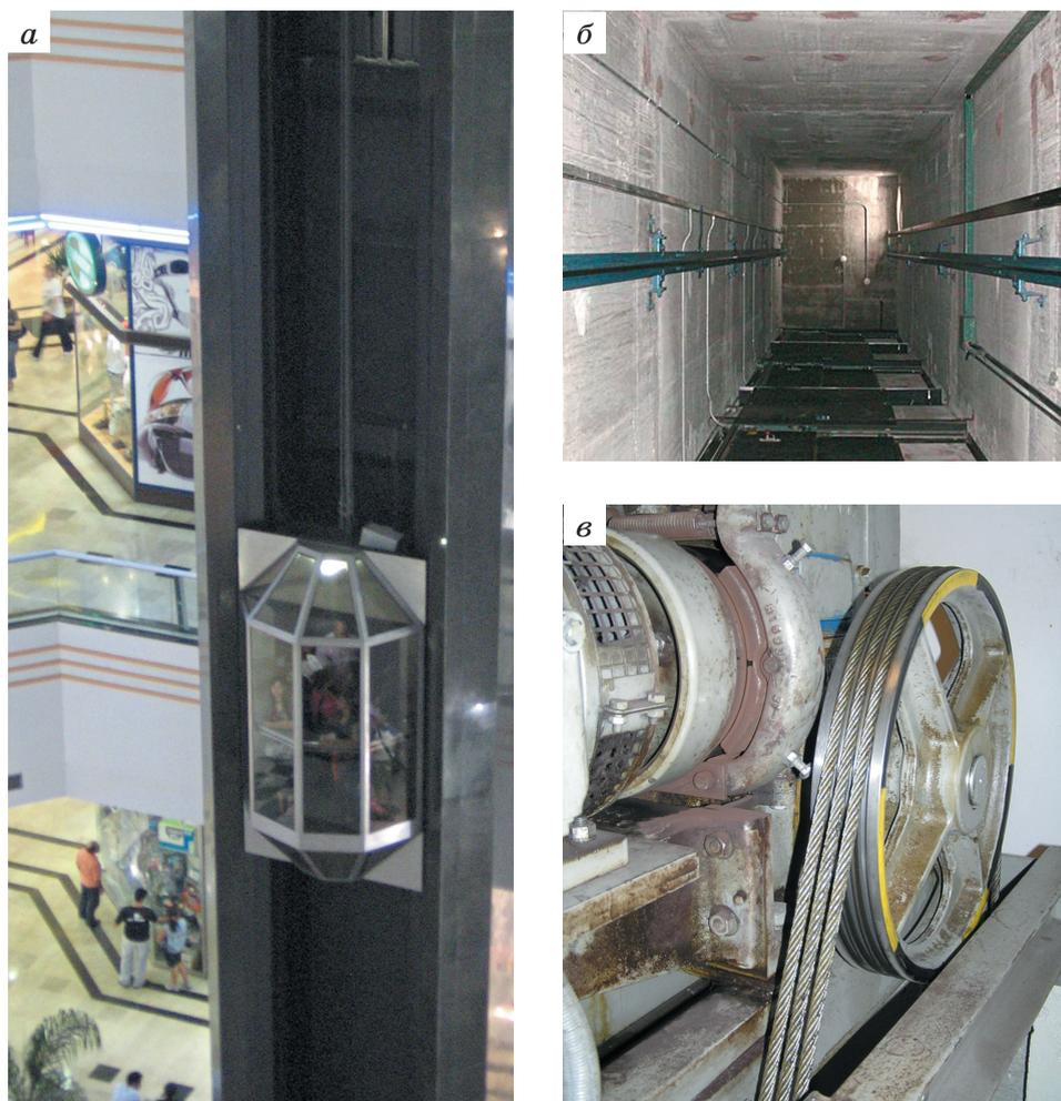
**Рис. 29.1.** Устройство лифта: *а* — кабина; *б* — шахта; *в* — лебёдка. Элемент конструкции лифта с каким приводом показан на рисунке 29.1, *в*? Почему вы так думаете?
